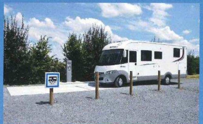
Installation de l'aire de vidange pour camping-cars à la Tricherie- Juin
