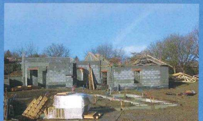
Début de construction des MAD (maisons adaptées aux personnes âgées) dans le Pré de la Fontaine
