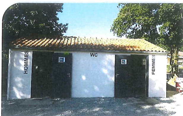
Rénovation des sanitaires - parking de la Tricherie – été
