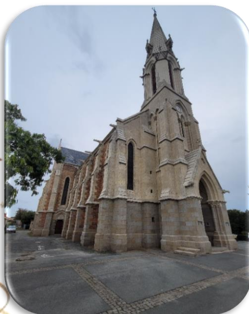
Nettoyage des façades de l'église Notre Dame
