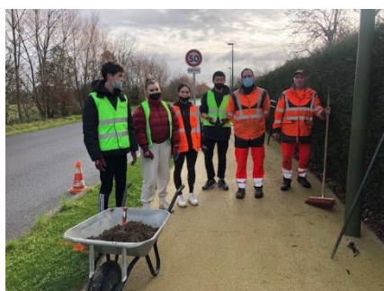
Pose de barrières – Route de St Fulgent
