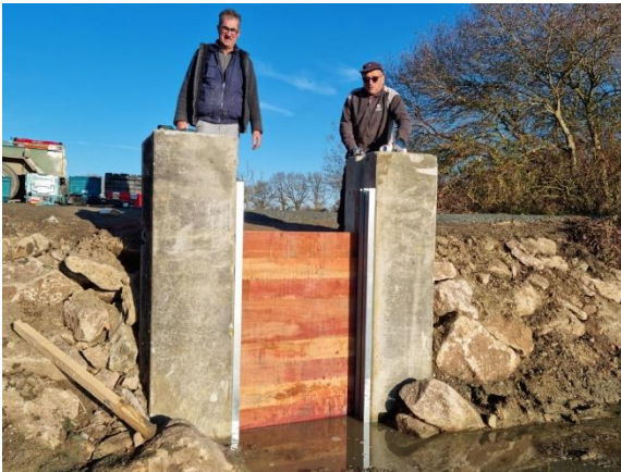
Mise en place d'un nouveau système de vidange sur le petit étang
