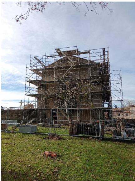
Début de la restauration de la Vieille Église
