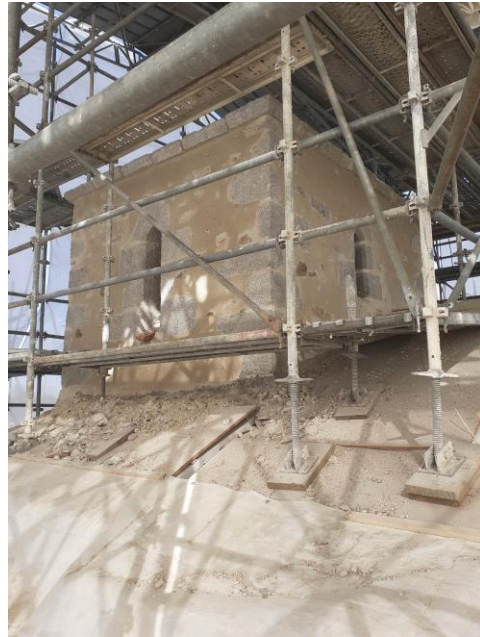
Réalisation des enduits du clocher
