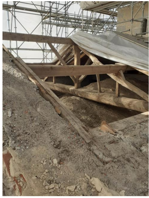
Dépose de la couverture sur la partie du cœur tour escalier et le clocher
