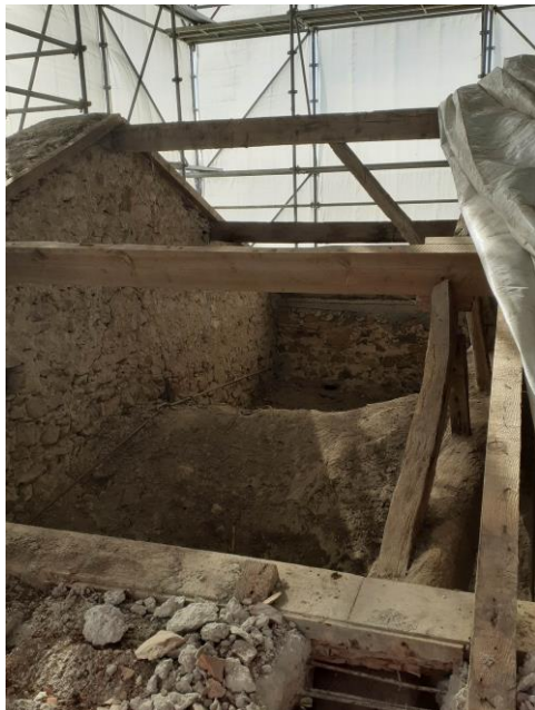
Dépose de la couverture sur la partie du cœur tour escalier et le clocher
